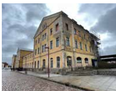
Bahnhof und Parkplatz
